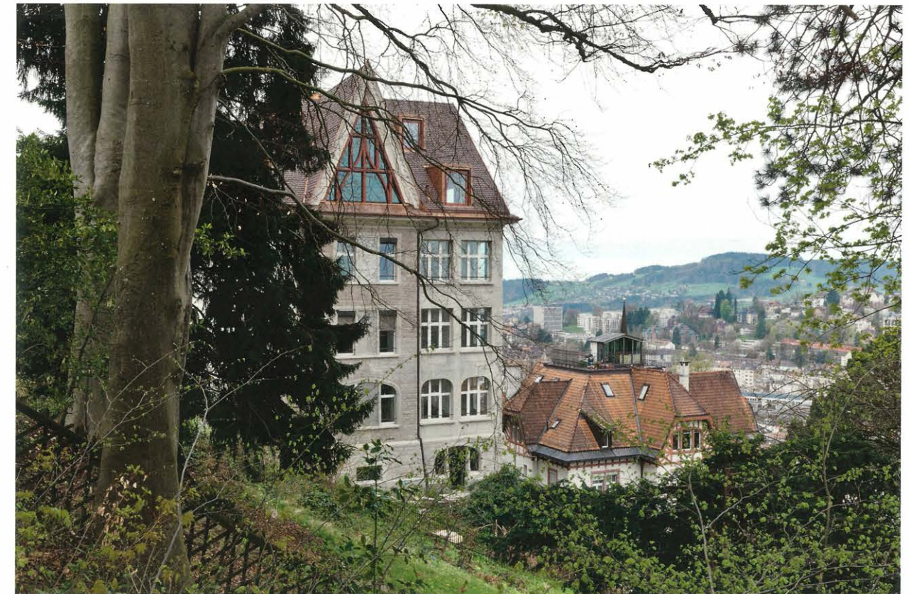
Der Giebel ist verglast, die Gauben nehmen die Farbe des Zierriegels auf. Die Kunststoffenster der Zwischengeschosse bleiben vorerst.
