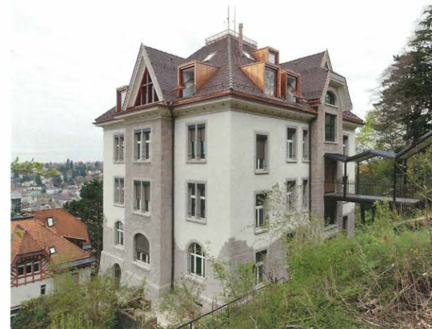
Danach: Kontrastreiche Farben und eine neue Dachlandschaft.
